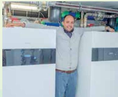
**OPTIMAL:** Die Wärmepumpen nutzen auch die Abwärme aus der Produktion.
