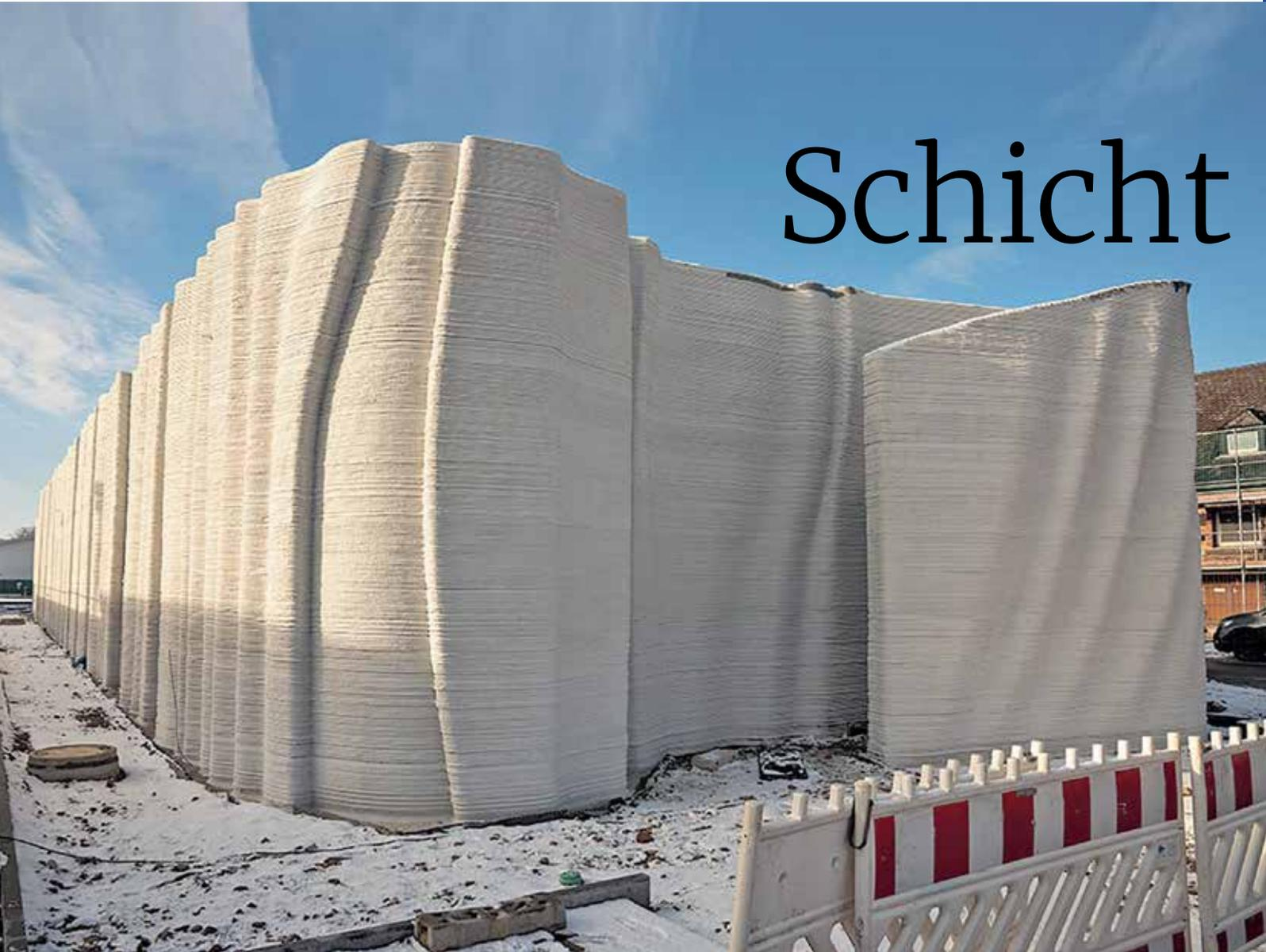
**333 TONNEN GEDRUCKTER BETON:** Das Wavehouse im Heidelberger Campbell-Quartier ist aktuell Europas größtes 3-D-gedrucktes Gebäude. Es wird als Rechenzentrum genutzt – deshalb hat es auch keine Fenster (Bild unten Mitte). Unten: Einblicke in den Druck-Prozess eines Wohnhauses im nordrhein-westfälischen Beckum.
