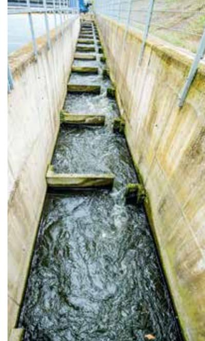
**RICHTUNGSWEISEND:** Fischtreppe mit 25 Becken am Wasserkraftwerk von Bad Ems. Dank geringer Strömung haben es die Fische leicht, sie zu überwinden.
