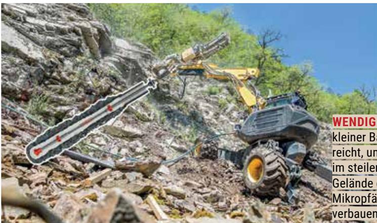
**WENDIG:** Ein kleiner Bagger reicht, um auch im steilen Gelände die Mikropfähle zu verbauen.
